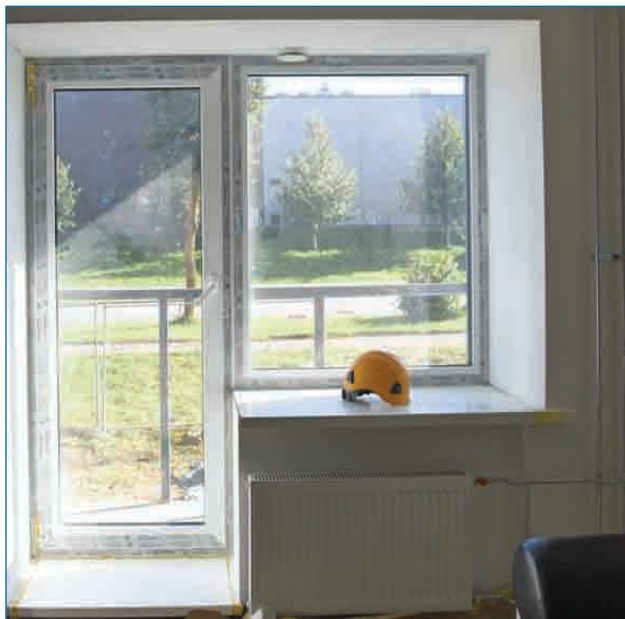
В квартире заменены радиаторы, установлены балкон, новые окна, подоконники и другие элементы для улучшения условий проживания.
